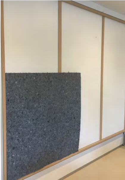
Paneel wordt prefab op locatie opgebouwd en gevuld met gerecycled katoen
