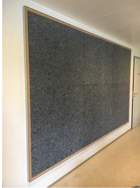
Paneel wordt prefab op locatie opgebouwd en gevuld met gerecycled katoen
